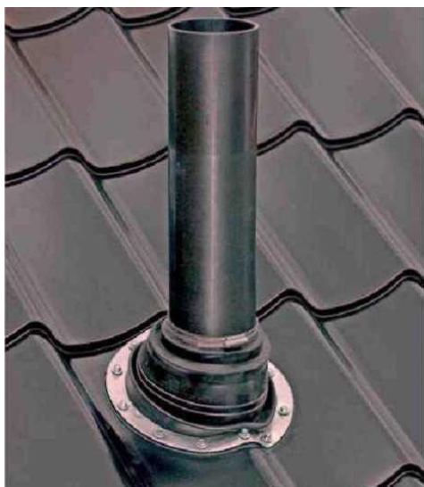
Рис.18. Выход фановой трубы в кровле Возможно применение выходов фирмы «Ондулин»
