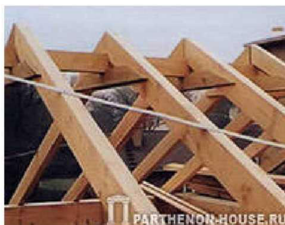
Рис. 33. Готовая стропильная система
