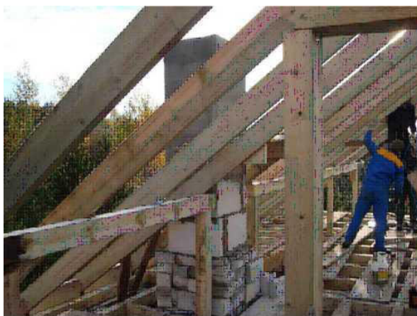
Рис. 33. Готовая стропильная система
