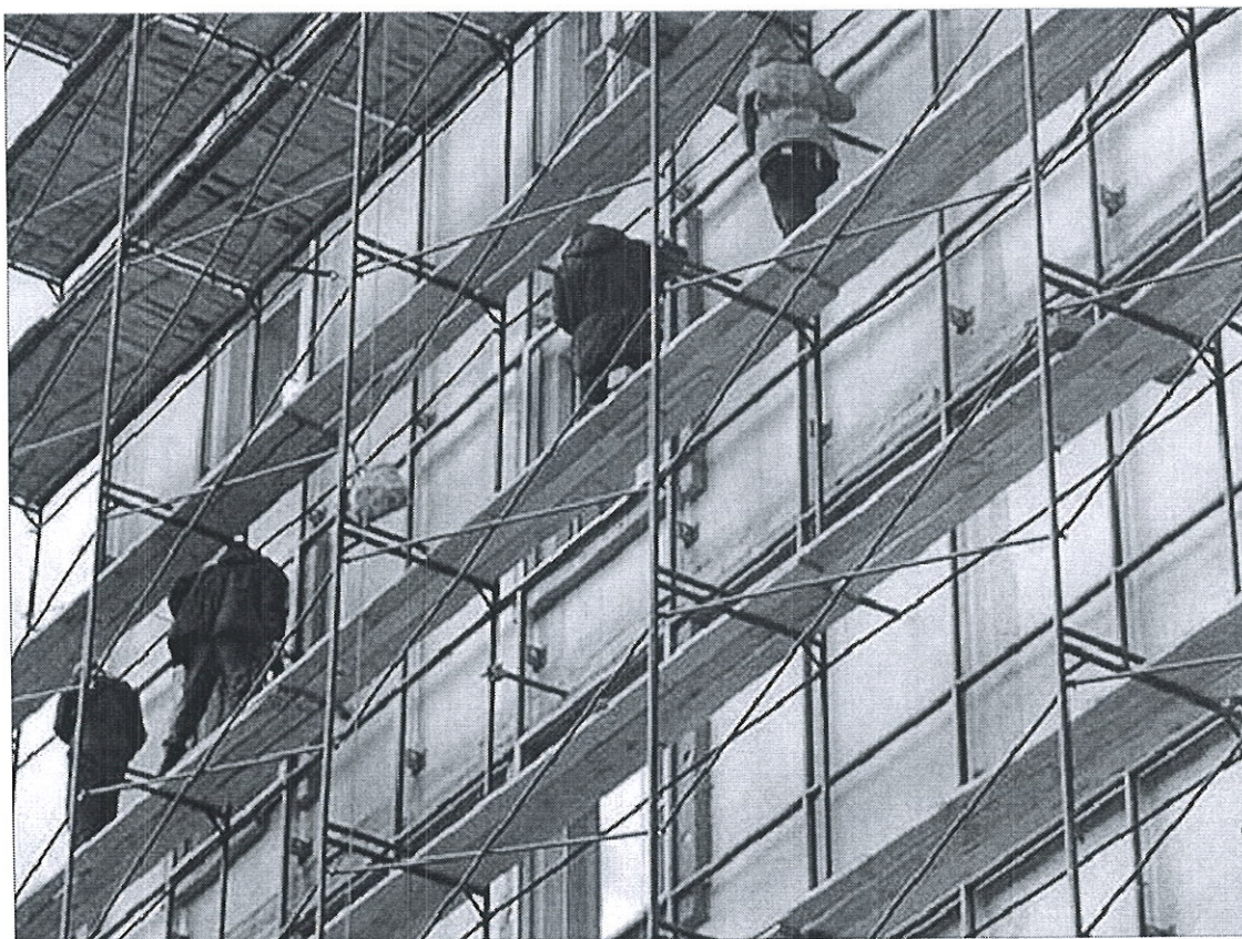
Рис.2 "а". Устройство лесов (пример)
