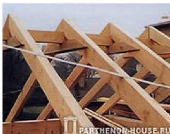
Рис. 33. Готовая стропильная система
