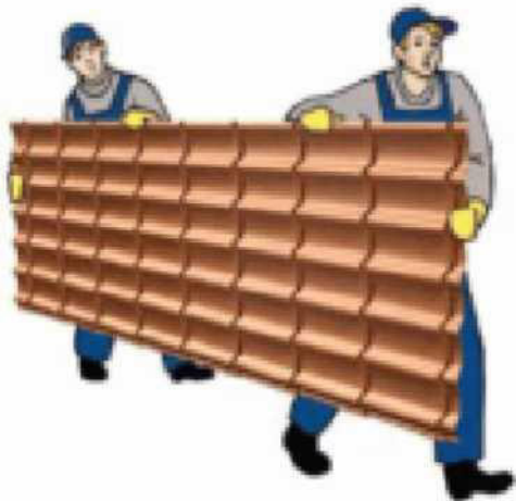
Рис. 4. Перенос профилированного листа
