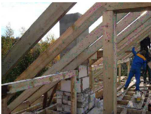
Рис. 33. Готовая стропильная система
